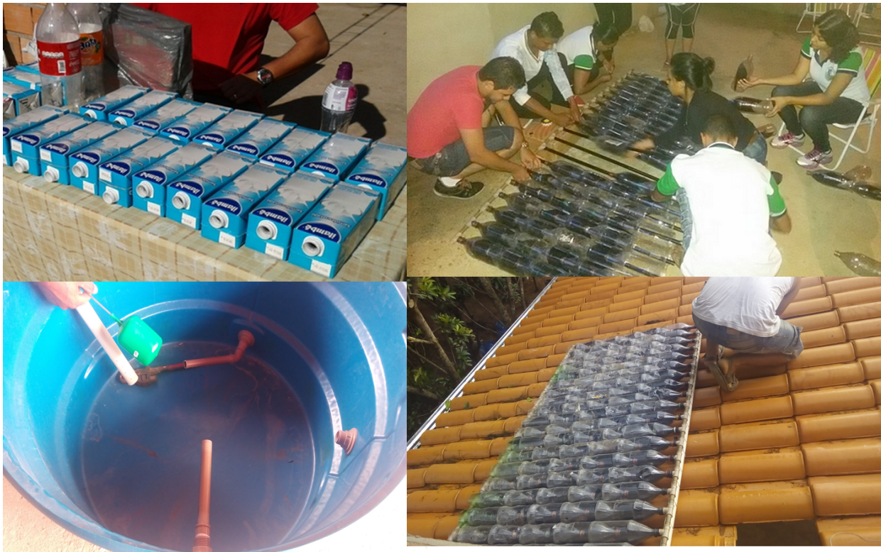
–Montagem do aquecedor solar
